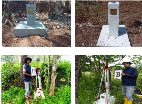
Gambar 3 Pemasangan dan Pengukuran Pilar Batas Wilayah
